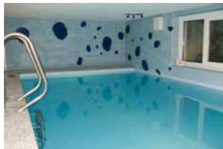
Installation privates Schwimmbad: Thierry Boissel; 23 gefusste Glaselemente
